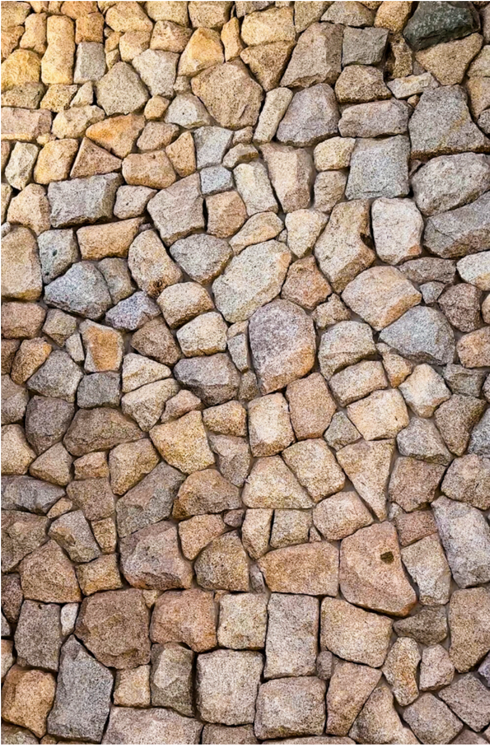
Parede em Pedra Moledo
